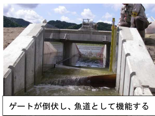
ゲート倒伏時の状況
