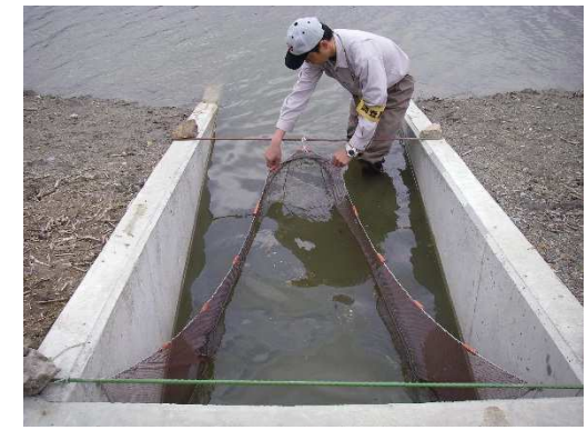
起伏ゲート整備後の遡上調査状況 (H21年4月)
